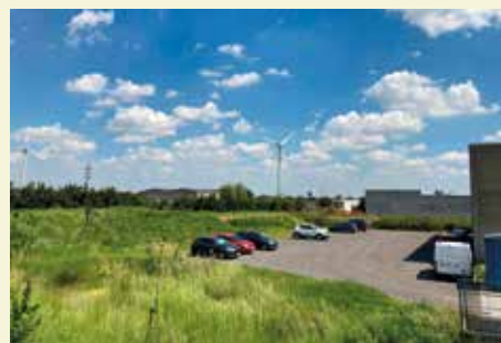
De nieuw aangelegde parking achter onze loods.
